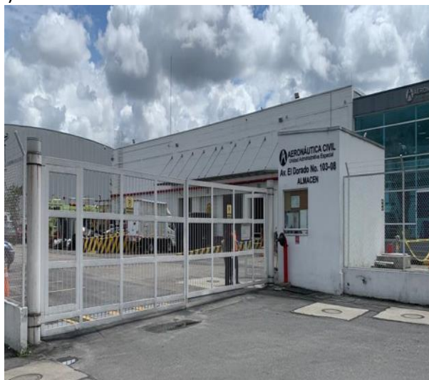
Fotografía 3. Nuevo Almacén De La Aeronáutica Civil (NAA)
