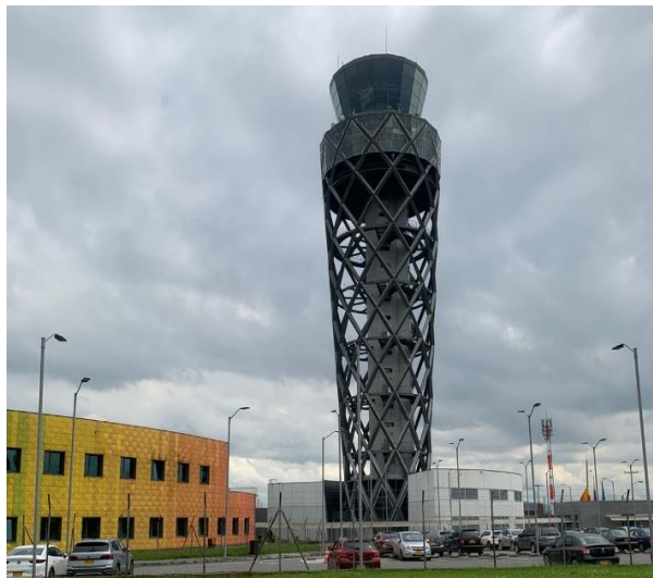
Fotografía 1. CGAC-Torre de control
